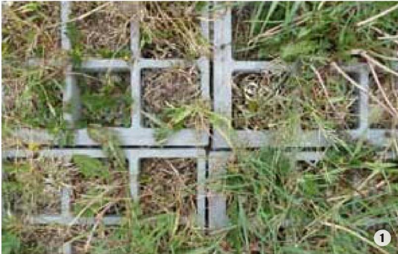
Bevor sie installiert werden, sollte der Mutterboden abgetragen, der Boden geebnet (mit Maximum 1% Gefälle) und ein Unterbau für die Befestigung angelegt werden. Dies soll verhindern dass sich die Platten lösen und die Fläche drainiert ist. Der Unterbau besteht aus einer Kiesschicht (5/32 oder 8/16 Körnung) von 10 cm, die auf einem Trennvlies liegt. Dann kommt eine Splitt-Schicht (2/5 Körnung) von 2 cm drauf.
